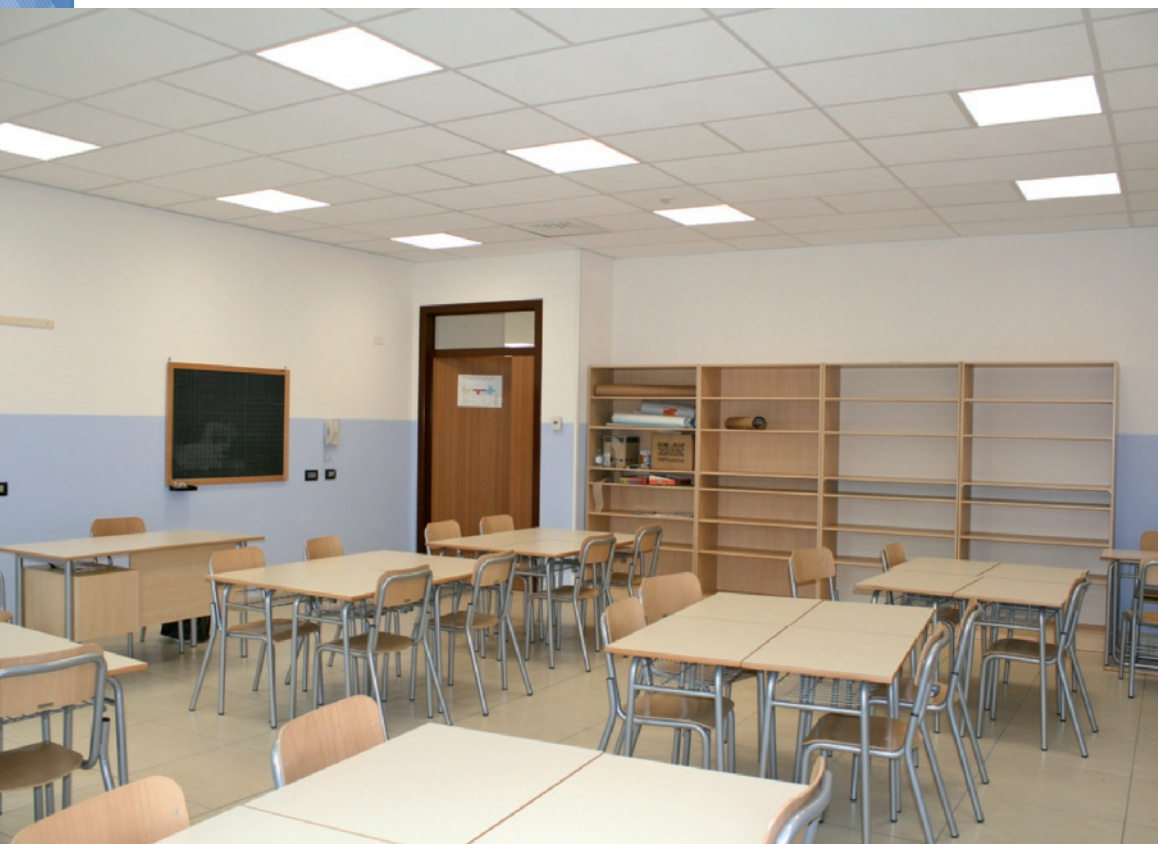
Veduta interna di una delle aule didattiche: l'impianto VMC immette l'aria di rinnovo attraverso diffusori dotati di microugelli rotabili, integrati nei controsoffitti, mentre la ripresa avviene da bocchette a parete.
