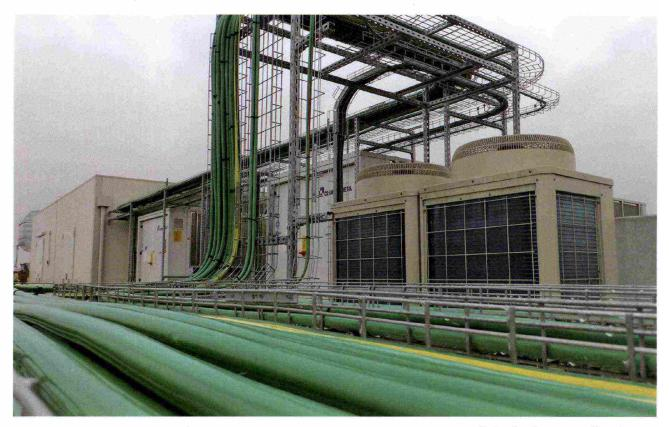
Le principali centrali termomeccaniche (unità esterne dell'impianto di climatizzazione, unità di trattamento dell'aria, produzione di a.c.s., ecc.), comprese quelle previste dalla variante, sono localizzate sulle coperture degli edifici (Ariatta Ingegneria dei Sistemi).
