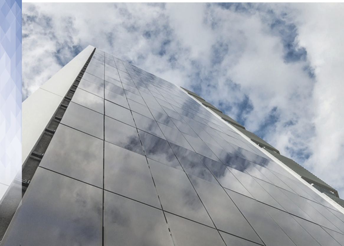
La facciata ventilata rivolta a sud è rivestita da 160 moduli fotovoltaici del tipo CIS che, assieme ai campi fotovoltaici posti sulla copertura, assicurano una produzione complessiva stimata in 51.300 kWh annui (Irene Taddei).
