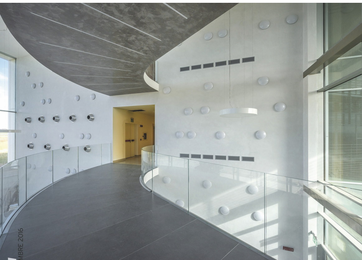
La hall d'ingresso su più livelli è attraversata da percorsi sopraelevati: l'immissione dell'aria avviene tramite ugelli a lungo lancio, incassati nelle contropareti che coprono tutta la superficie utile (Irene Taddei).
