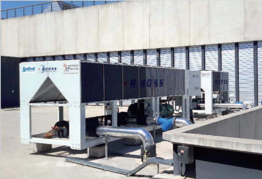
Dos enfrriadoras de agua monobloque con condensación por aire y ventiladores helicoidales, compresores semiherméticos de tornillo de alta eficiencia energética y gas refrigerante R134a y con una ejecución especial en el modelo 2331 para trabajar con agua glicolada a -8 °C, dan servicio a la climatización de esta bodega.
