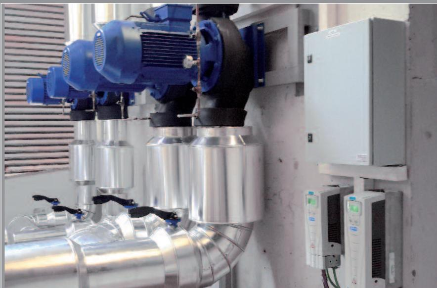
tica y gas refrigerante R134a, y con una ejecución especial en el modelo 2331 para trabajar con agua glicolada a -8 °C, dan servicio a la climatización de esta bodega siendo gestionadas e integradas por Modbus desde un CENTRAWebPlus, un controlador multiprotocolo de gran capacidad y altas prestaciones.
